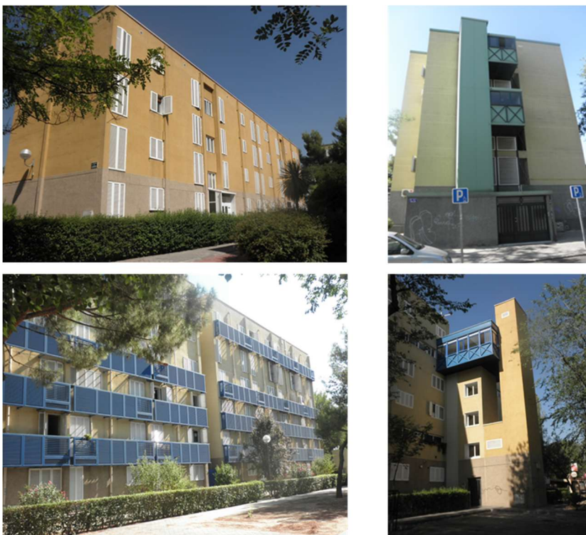
Figura 2. Imágenes de los edificios rehabilitados en el P.D. de Caño Roto (fotografías tomadas por el autor)
